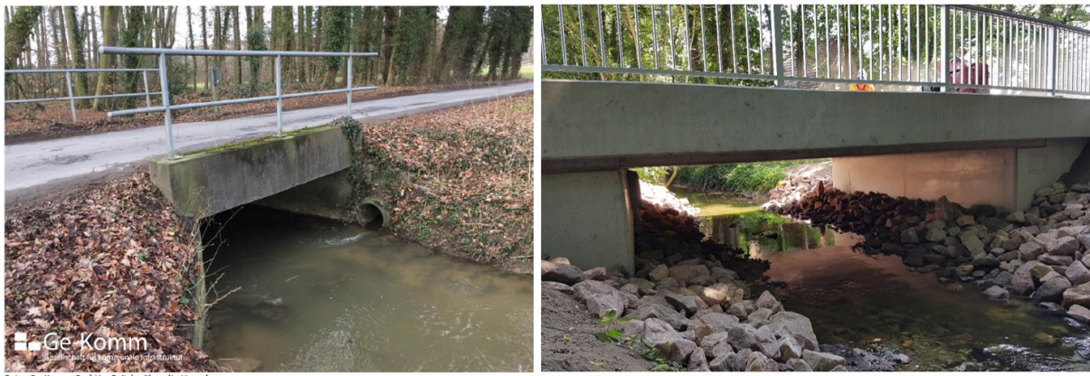
Abb. 3: Erneuerung der Brücke unter Berücksichtigung ökologischer Aspekte (Bild 2: Bezirksregierung Detmold)
