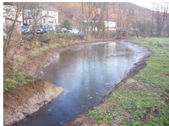
Hier wurde zur Wasserrückhaltung das vom Hang kommende Oberflächenwasser von einem kleinen Graben aufgenommen und gleichzeitig für Amphibien eine Fläche geschaffen. Der Teich wurde mit einem Überlauf angelegt (Rohr), alternativ wäre auf dem kleinen Damm eine Mulde als Überlauf möglich gewesen, die hier geschaffene Lösung hat sich jedoch bewährt.
