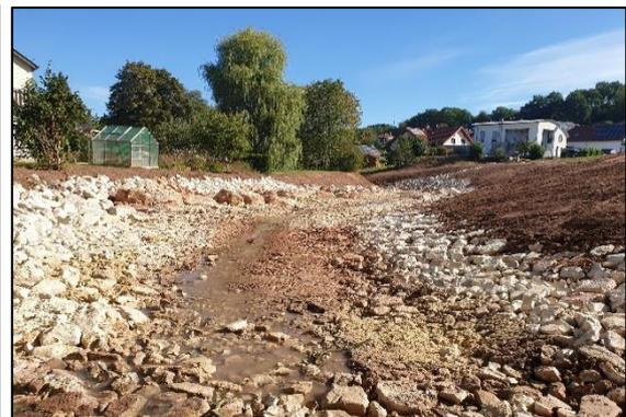
Abbildung 3: Aufweitung des oberen Wiesbach
