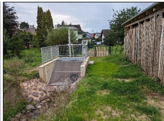
Abbildung 7: Neues Einlaufbauwerk am Haaggraben
