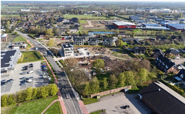
Gesamtansicht des im Bau befindlichen neuen Dorfcentrums
