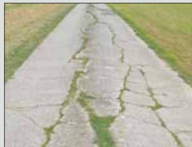
Abb. 2: Durch Überbelastung und fehlende Tragfähigkeit zerstörte Wegestruktur
