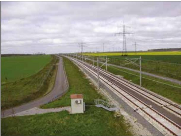
Abb. 1: Trasse mit Bahnseitenweg und Trasseneingrünung
