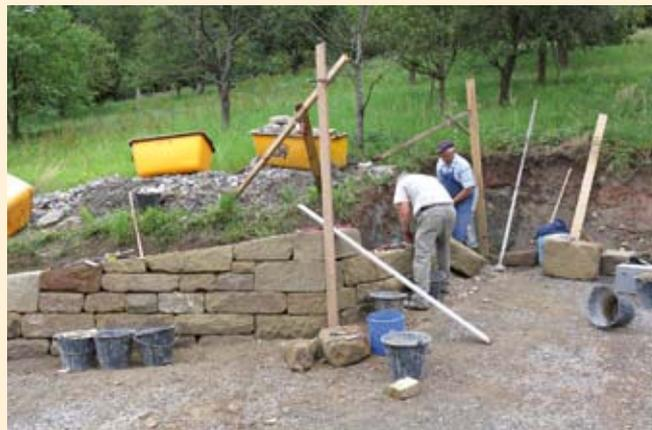
Abbildung 3: Bau von Trockenmauern
