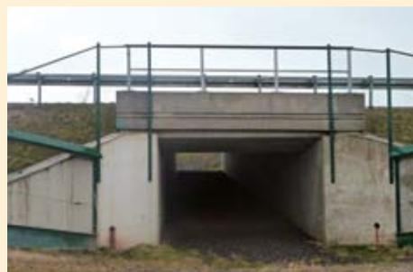
Abbildung 4: Rahmendurchlass unter der umverlegten BAB A 4
