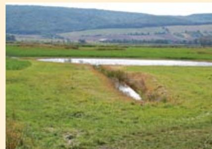
Abbildung 2: Flutmulde mit Zulaufgraben
