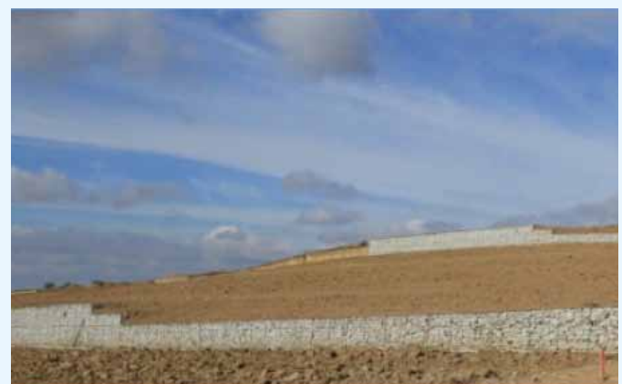
Abb. 23: Mauersanierung und Freistellung
