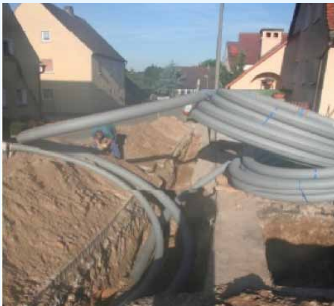
Abb. 28: Aktive Bürger gehen die Energiewende an: Verlegung des Nahwärmenetzes in Eigenleistung
