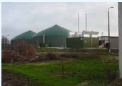
Abb. 4: Biogasanlage in Nettegau im Altmarkkreis – Quelle: www.altmark.eu
