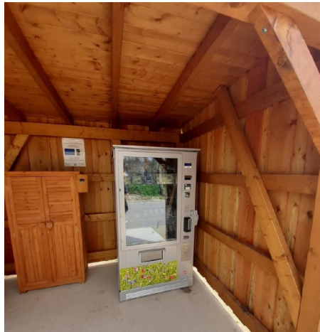
Versorgungsstation inkl. Elektroschaltschrank, Regio-Box, Wanderer- Schrank
