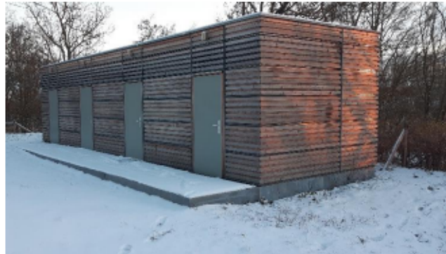
Mehrzweckgebäude einschl. Sanitäranlagen Foto: Stadt Angermünde
