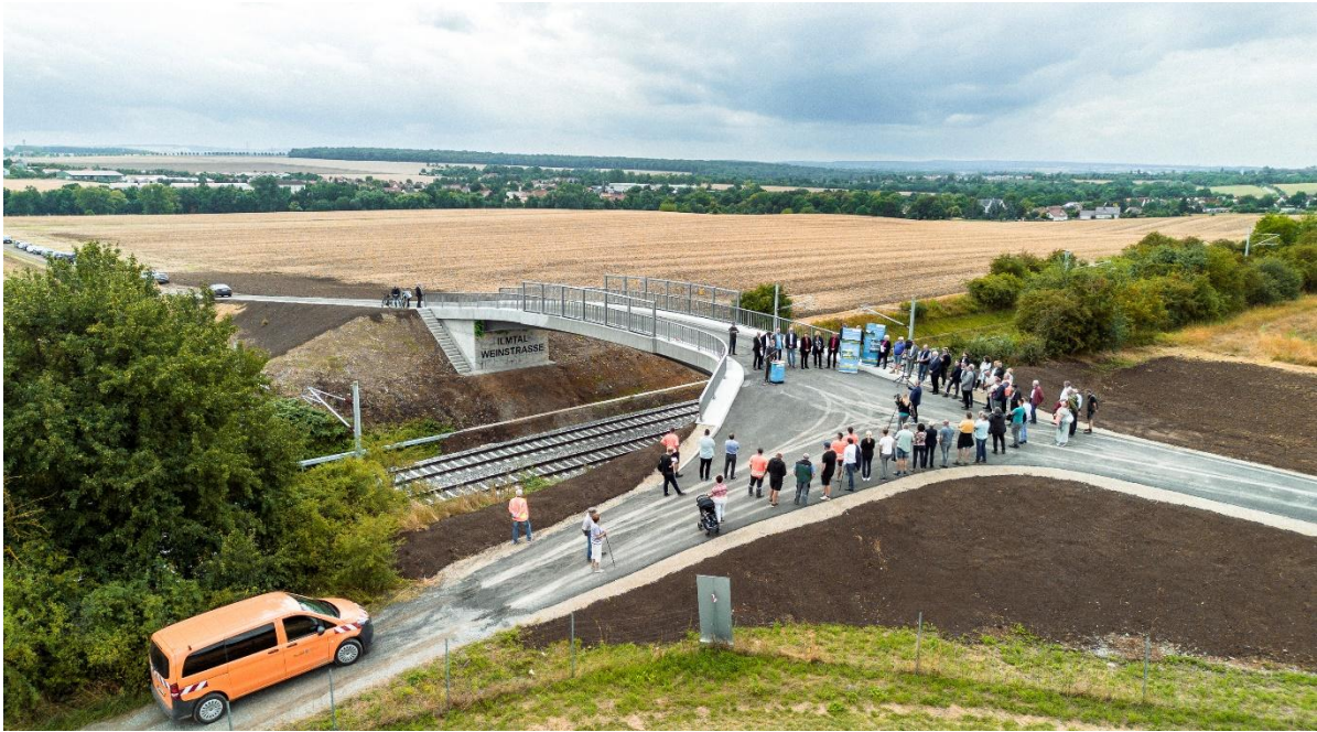
Abb. 4: Gesamtansicht des neuen Brückenbauwerks mit den Anrampungen der anschließenden ländlichen Wege
