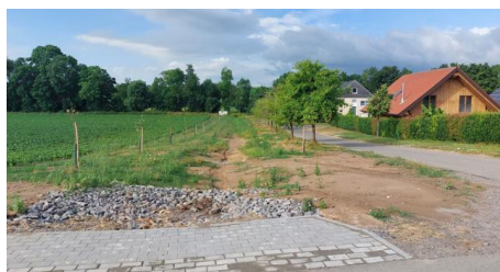
Naturnaher Umbau des Oberflächengrabens
