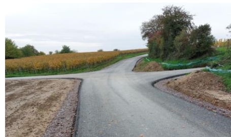
Wirtschaftsweg nach dem Wegebauverfahren
