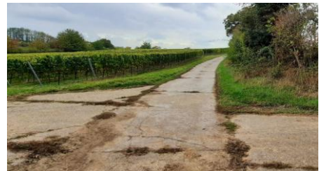
Wirtschaftsweg vor dem Wegebauverfahren
