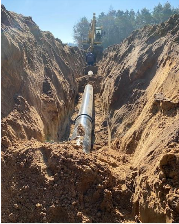
Abb. 3 – Einbau der neuen Leitung (PE-Rohre DN 300)
