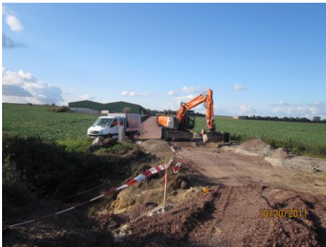
Einbau von Frostschutz und Tragschichten
