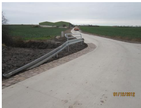
Fertigstellung der Nebenanlagen
