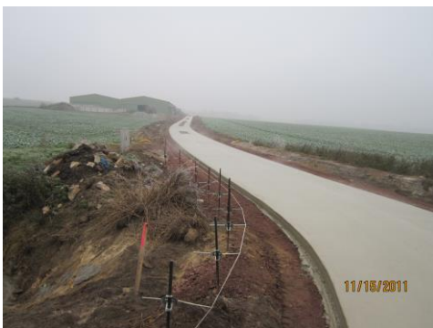
Einbau Spurbahn erfolgreich abgeschlossen
