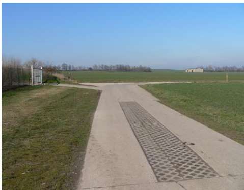
Bauende im Jahr 2022 – guter Erhaltungszustand
