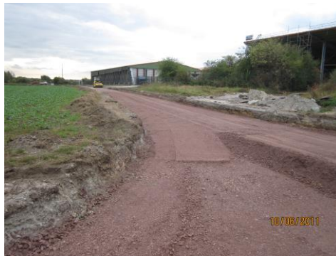
Lageweise Verdichtung - bis 0,80m Einbaustärke
