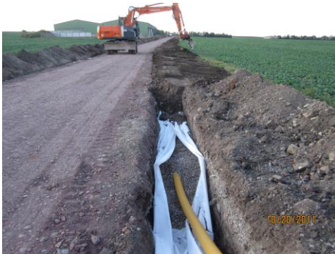
Drainsammler DN 100 beidseitig des Weges
