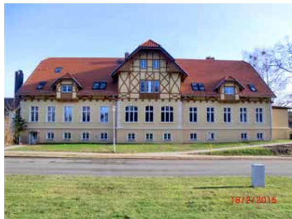
Gutshaus nach der Sanierung
