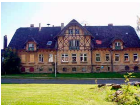
Gutshaus vor der Sanierung
