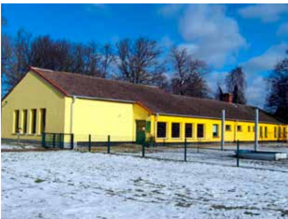
Das Gebäude der „Alten Kita“ vor der Durchführung der Maßnahme (Foto: Gemeinde Steinhagen)
