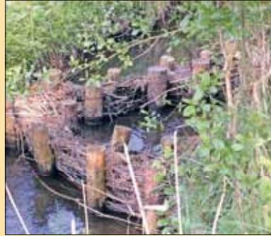
Abb. 5: Ingenieurbio-logische Bauweisen zur Sohlanhebung und Laufveränderung
