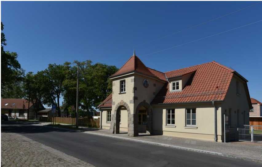
Bürgerhaus „Alte Schäferei“ nach der Sanierung (Foto: Manfred Lange)
