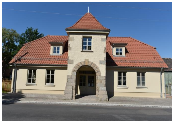
Bürgerhaus „Alte Schäferei“ nach der Sanierung (Foto: Manfred Lange)
