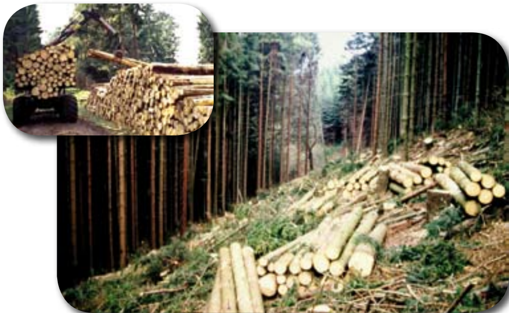
Abb. 9 u. 10: Ein wesentlicher Strukturmangel im Wald ist die unzureichende Erschließung. Das Beispiel aus Rheinland-Pfalz zeigt die vorbereitenden Arbeiten für die Herstellung eines neuen Wirtschaftsweges.
