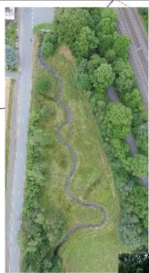
Verlegung der Dill in den Tiefpunkt der Aue
