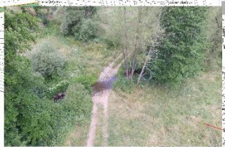
Herstellung einer Furt durch die Dill
