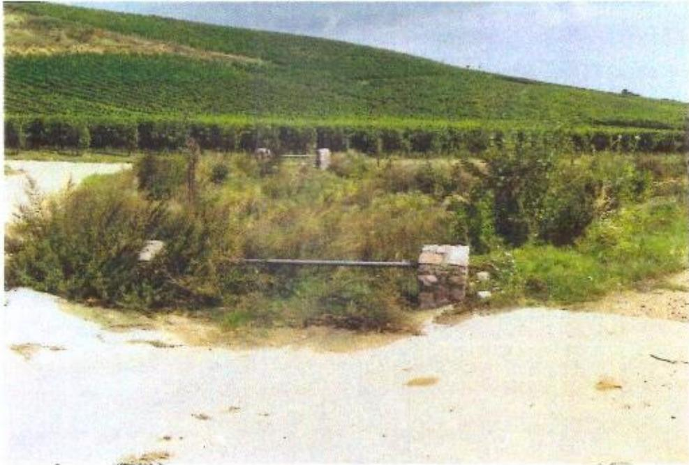
Bild 25: Vorderseite eines Sicker- und Verdunstungsbeckens
