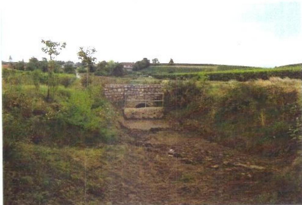
Bild 20: Schlammfangbecken
