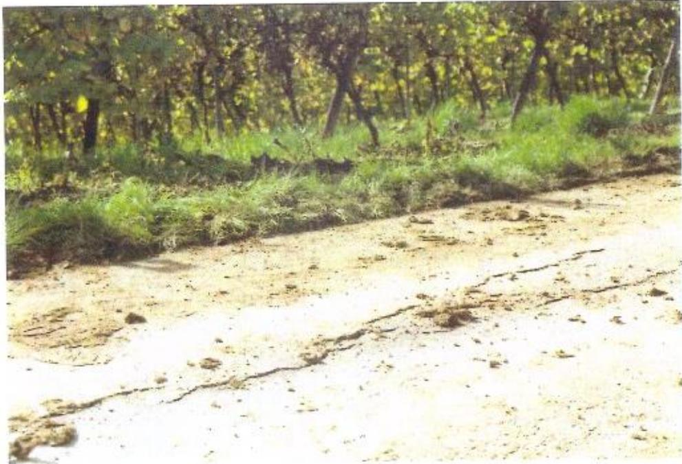
Bild 15: Risse in der Asphaltdecke
