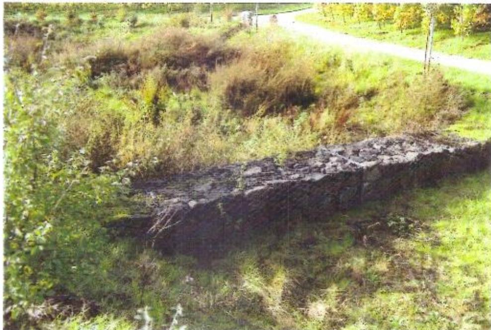
Bild 26: Rückseite eines Sicker- und Verdunstungsbeckens
