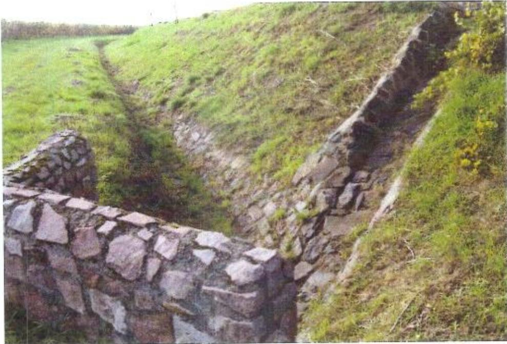
Bild 23: Mittlere Stufe eines Knotenpunktes der Wasserführung
