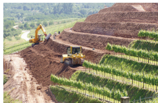
Terrassenbau mit Bagger und Planierraupe in der Ortenau (Quelle: Landratsamt Ortenaukreis; Vermessung & Flurneuordnung)
