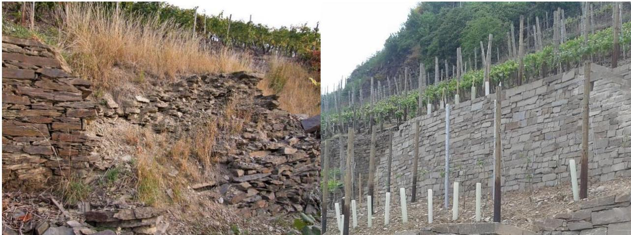
Abbildung 2: Beispiel einer Mauersanierung (Jacoby, 2014)
