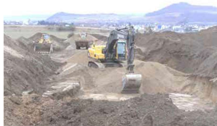
Bimsabbau im Bereich der Straße [DLR Westerwald-Osteifel]
