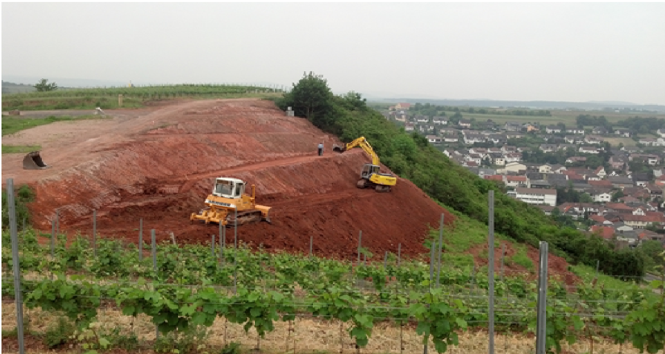
Abb. 1: Bau einer Querterassierung im Flurbereinigungsverfahren Wallhausen [Quelle: DLR Rheinhessen-Nahe-Hunsrück]
