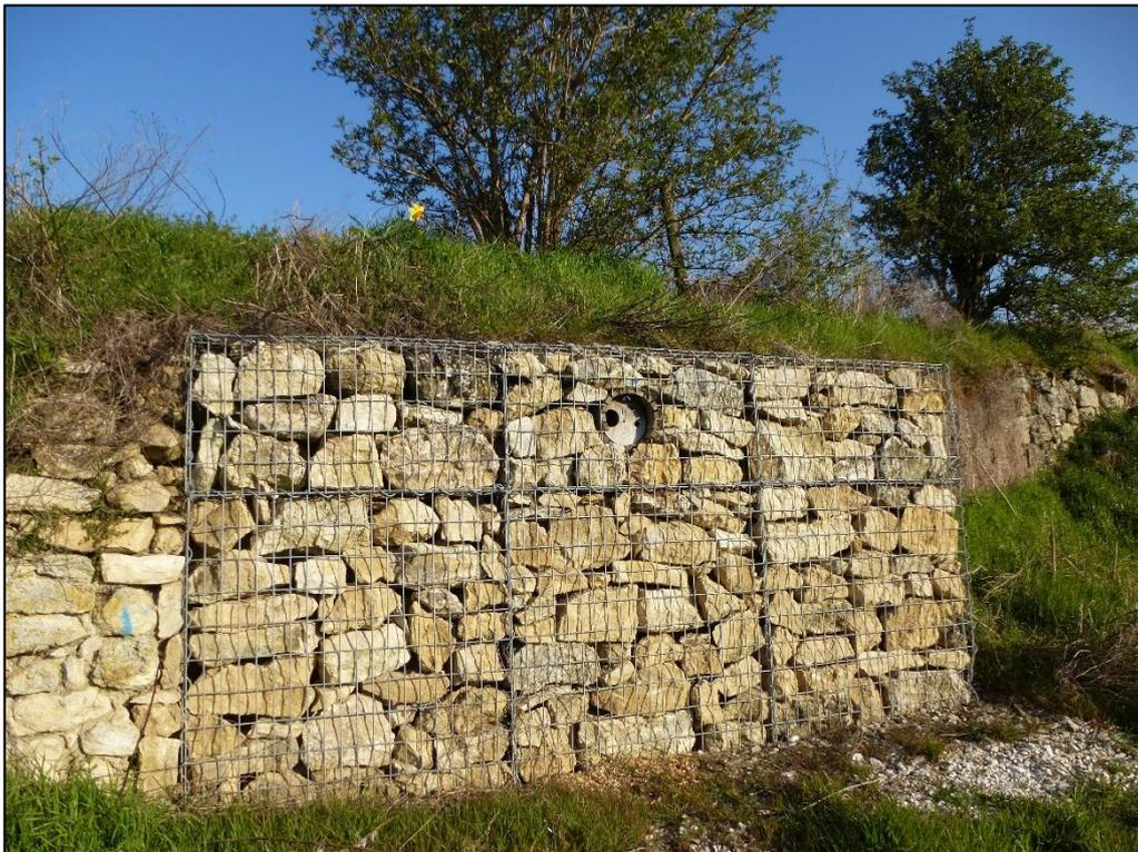
Abbildung 5 – 2: Gabionenmauer mit integrierter Brutröhre [DLR RNH (2021)]
