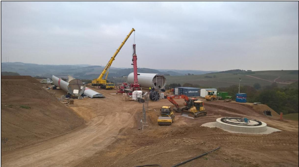
Abbildung 4 – 5: Bau einer WKA und des Erschließungsweges in Lünebach [DLR Eifel (2021)]
