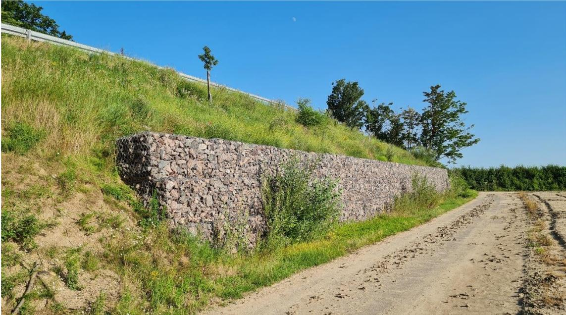
Abbildung 22: Gabionenkörbe zu Absicherung des Hanges (eigene Aufnahme vom 18.07.2021)
