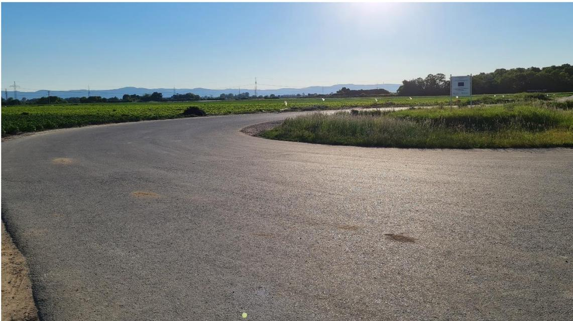
Abbildung 15: Erweiterter Kurvenradius an der Zufahrt zur L524 (eigene Aufnahme vom 01.06.2021)
