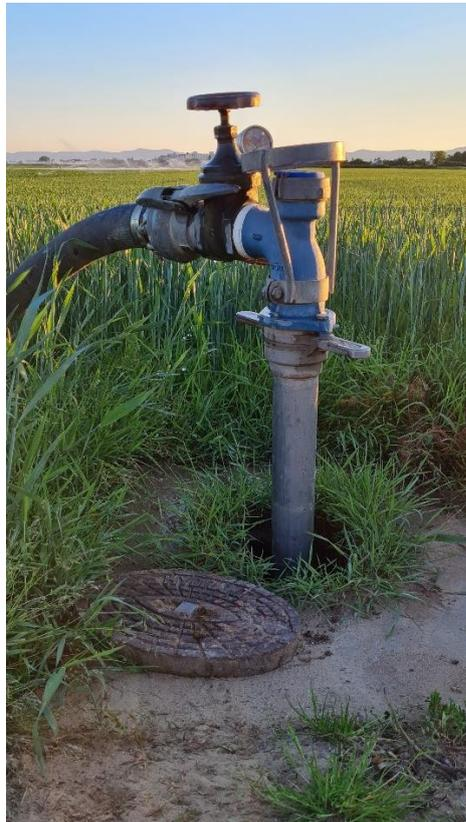
Abbildung 26: Hydrant mit Standrohr (eigene Aufnahme vom 31.05.2021)
