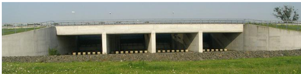
Abbildung 39: Ein- und Auslassbauwerk Polder Bodenheim/Laubenheim
