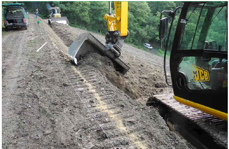
Abb. 17: Abziehen der Böschung mit Hilfe des Baggers entlang eines Sägemehlstreifens
