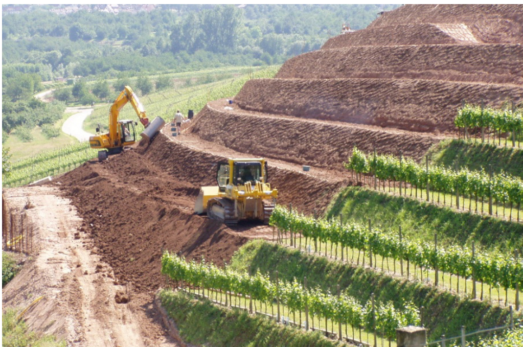
Abb. 38: „Anmodellierung“ der neuen Terrassen an die vorhandenen
