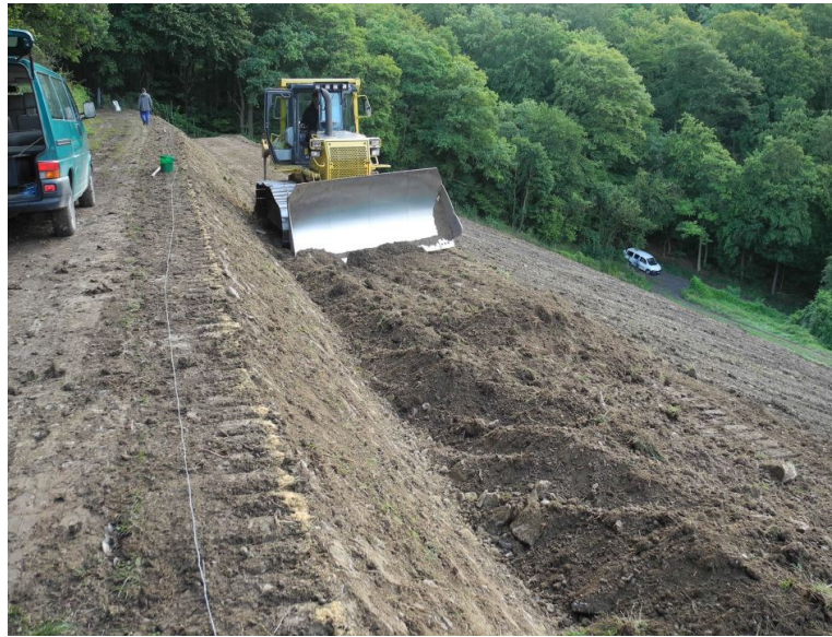
Abb. 18: Einebnen der Terrassenplattform mit Hilfe der Planierraupe
