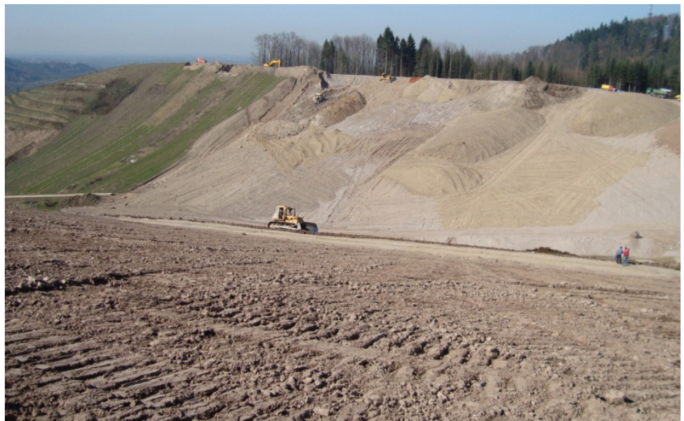
Abb. 34: Westseite während der Planiearbei- ten
