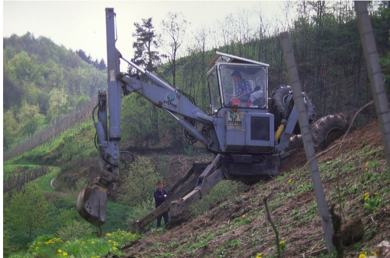
Abb. 15: Menzi-Muck beim Terrassenbau
