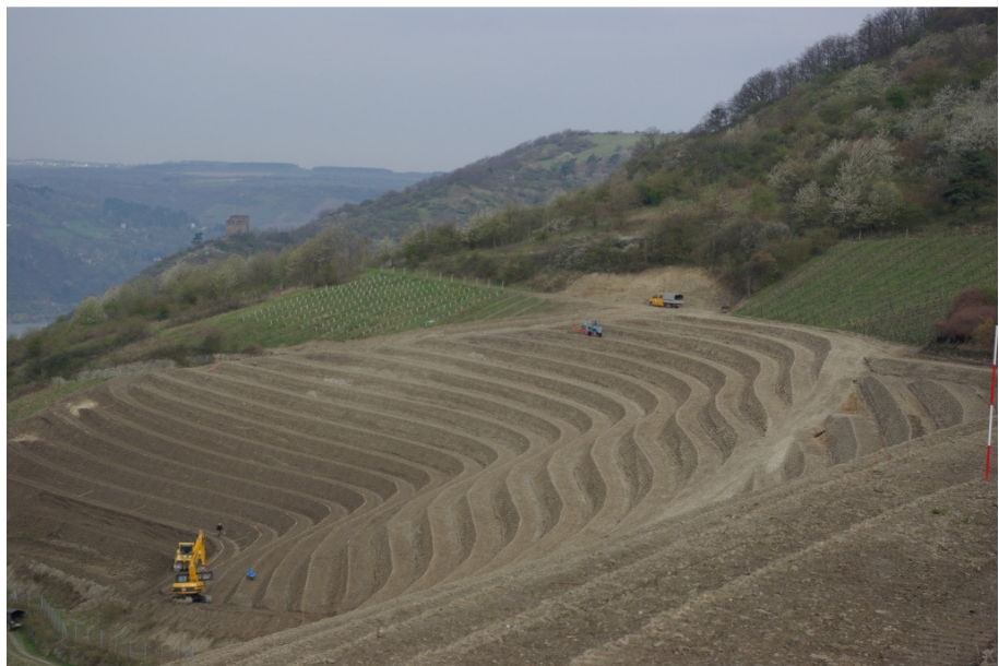
Abb. 50: Bau der Querterrassen mit Planierraupe und Bagger in der obersten Tafel
