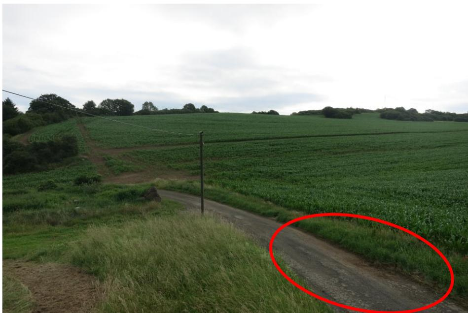
Abbildung 26: Erosionsschäden am Asphaltweg zur Lavagrube [Quelle: eigene]
