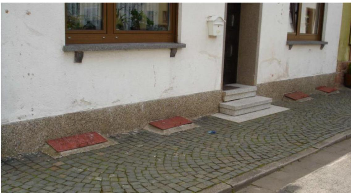
Abbildung 40: Lösungsmöglichkeiten bei einem Lichtschacht
