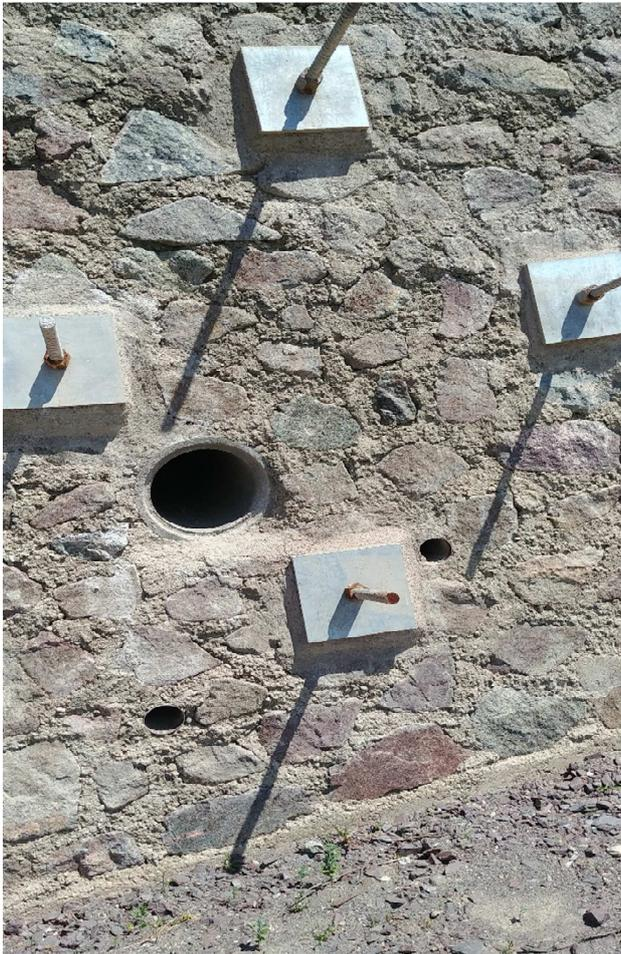
Abbildung 23: Erdstützscheiben an Stützmauer
