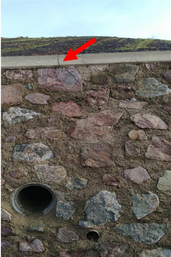
Abbildung 6: Schäden an der Stützmauer unter Kontrollpunkt 45
