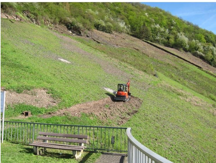
Abbildung 19: Bau einer Querterrasse mittels Kleinbagger
