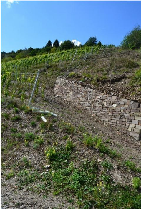
Abbildung 29: Trockenmauer an einer Querterrasse in Klotten
