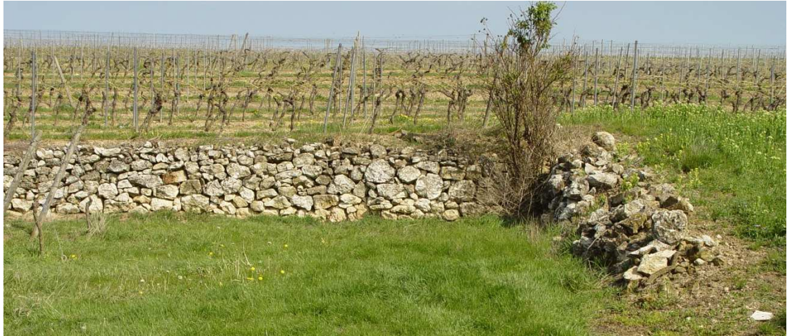
Abbildung 11 Trockenbaumauer Gundersheim-Höllenbrand I
