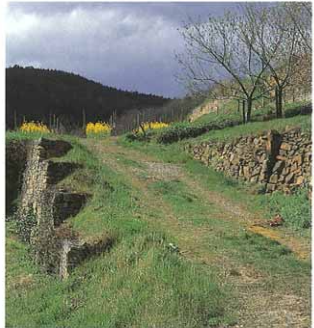
Erschließung der Weinbergsterrassen über geschotterte Rampen
