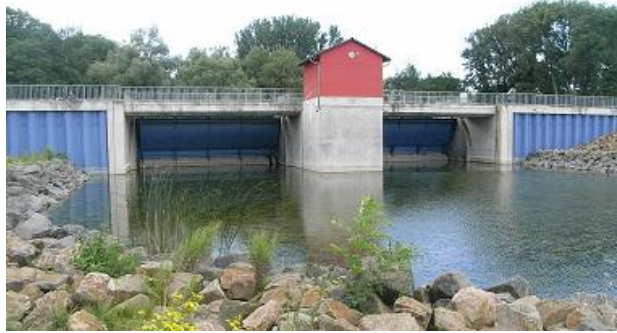
Abbildung 50: Ein- und Auslassbauwerk Polder Ingelheim
