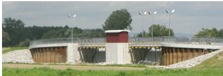
Abbildung 62: Ein- und Auslassbauwerk HWR Wörth-Jockgrim
