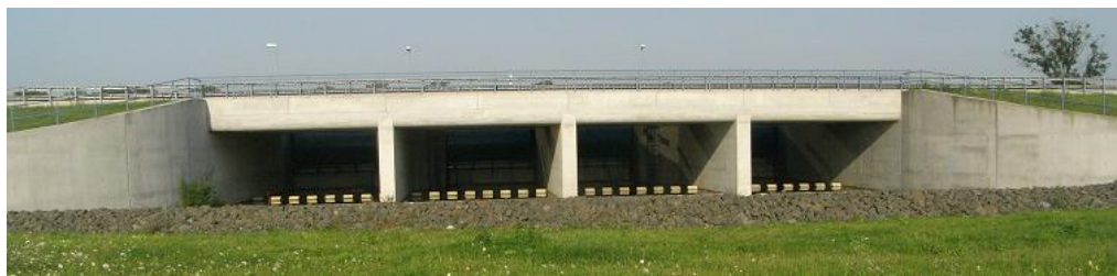
Abbildung 39: Ein- und Auslassbauwerk Polder Bodenheim/Laubenheim
