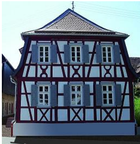
Abbildung 64: Rheinauen- und Hochwasserschutz-Informationszentrum 62
