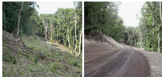
▶ Abb. 9 und 10: Situation im Hang- bereich vor und nach dem Waldwegebau
