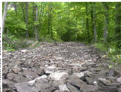
◀ Abb. 8: Wegebau in ver- nässten Bereichen mit sog. Krotzen
