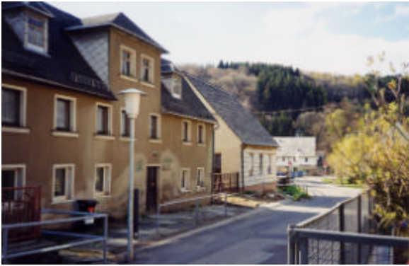
Abb. 2: Bauphase - Verbesserung der Infrastruktur, Trinkwasserversorgung /Energie/Telekom
