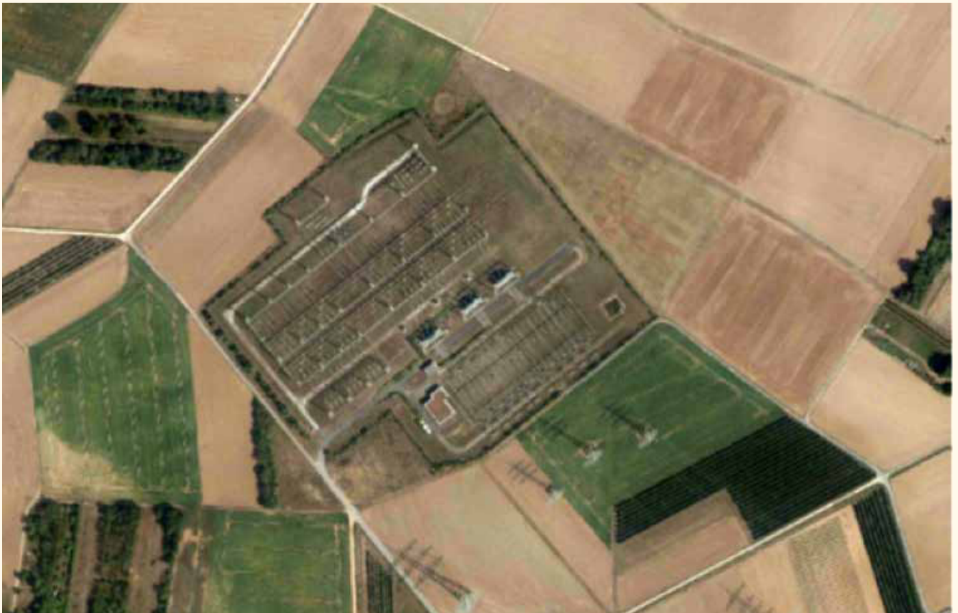
Abb. 1: Luftbild Umspannwerk nach der Realisierung
