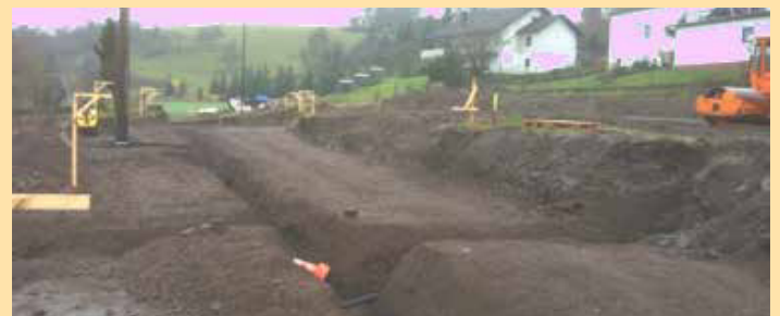
Abb. 5: Neue Erschließungsstraße im Ausbau
