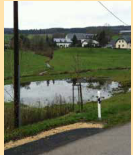
Abb. 5: neue Rückhaltemulde am Mönbach
