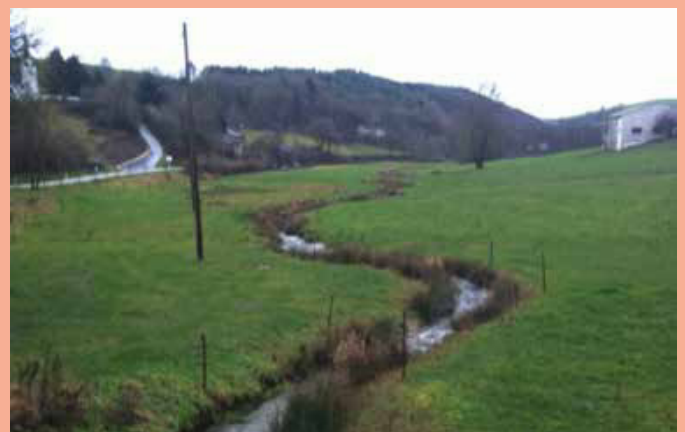
Abb. 6: Gewässerverlauf nach Renaturierung im Tiefpunkt der Talaue
