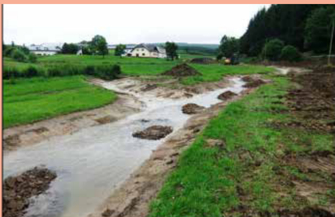
Abb.2: Sohlsubstrateinbau im neuen Gewässerbett
