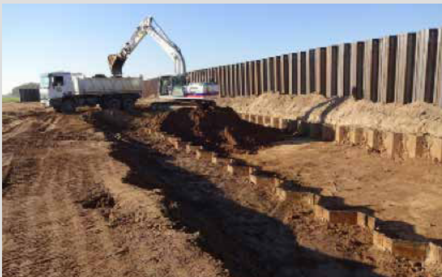
Abb. 4: Deichbauarbeiten bei Löbnitz
