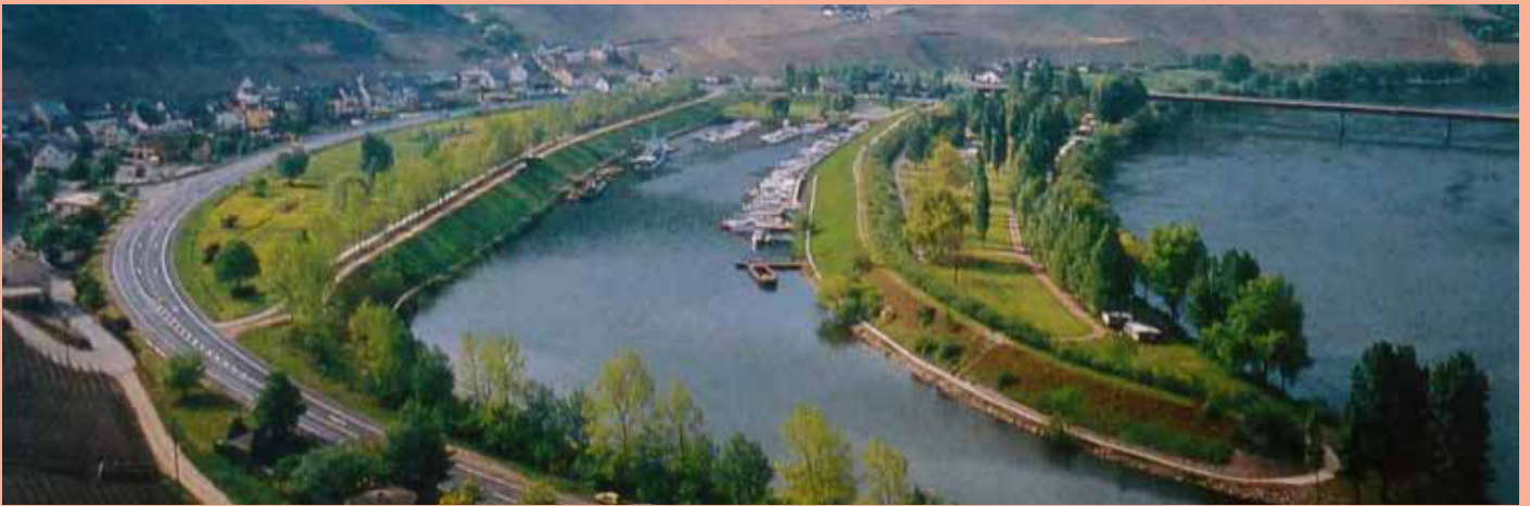
Abb. 3: Blick auf den neugestalteten Senheimer Hafen
