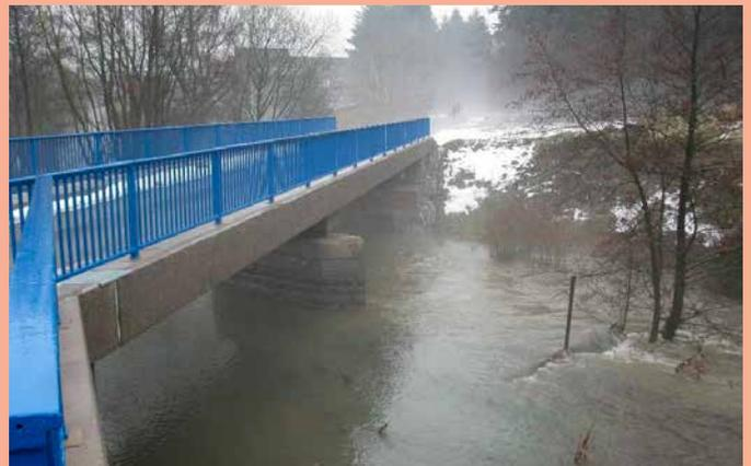
Abb. 4 und 5: Wiedergenutzte ehem. Eisenbahnbrücke mit neuem Überbau auf alten Widerlagern
