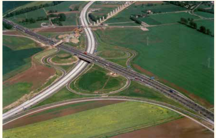
Abb. 1: Autobahnkreuz Erfurt 1998 mit in Bau befindlicher ICE-Strecke
