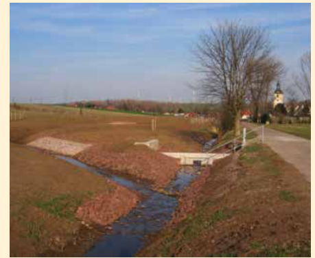
Abb. 4: Regenrückhaltebecken Bergborn westlich der Ortslage Molsdorf
