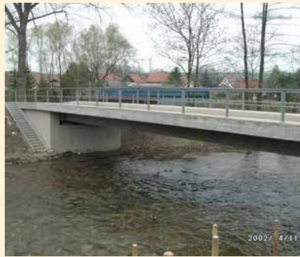
Abb. 3: Brückenneubau über das Gewässer Apfelstädt bei Ingersleben
