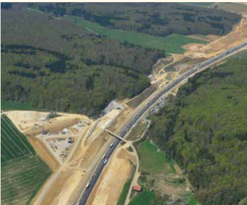
Abb. 2: Luftbild: Baustelle im Bereich von Temmenhausen
