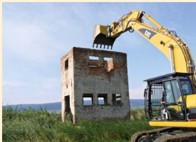
Abbildung 1: Abriss der Ruine des alten Vogelbeobachtungsturms
