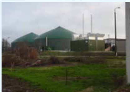
Abb. 4: Biogasanlage in Nettegau im Altmarkkreis – Quelle: www.altmark.eu
