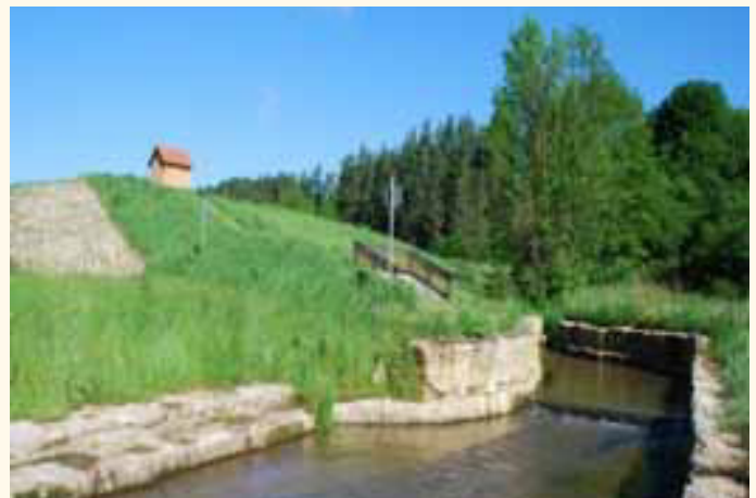
Abb. 3: Ein 100 Meter langer und bis zu 5 Meter hoher Damm schließt das schmale, langgezogene Silberbachtal ab.
