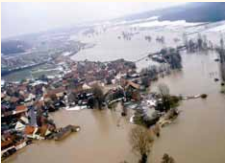
Abb. 1: Nicht nur die breite Rezataue, sondern häufig auch Ortslagen wurden vom Hochwasser heimgesucht, das dort zuweilen schwere Schäden an Haus und Hof hinterließ.
