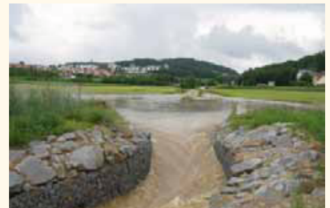
Abb. 3: Hochwasser am Krumbach im Juni 2013
