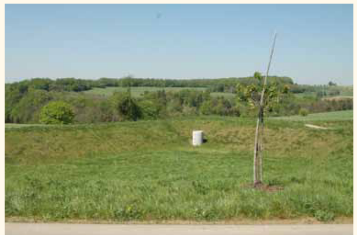
Abb. 2: Fertiggestelltes, naturnahes Becken
