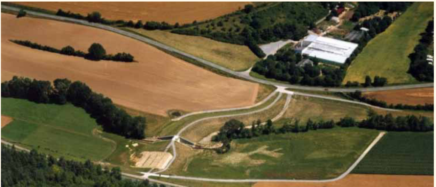
Abb. 5: Hochwasserdamm und Einstaufläche
